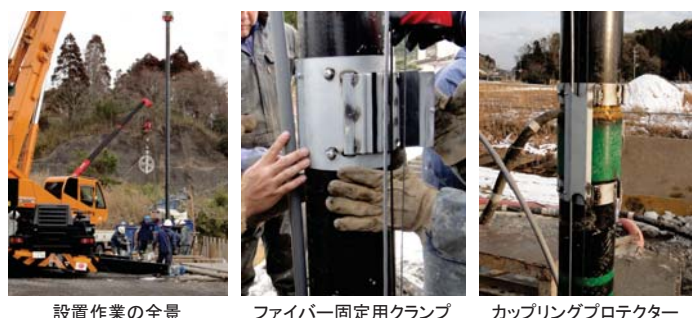
設置作業の全景
