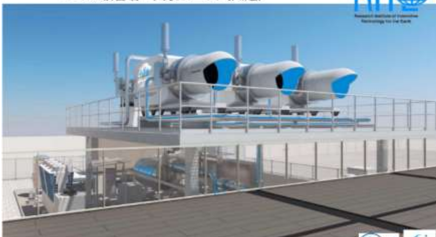
パイロットスケール試験機イメージ 3つの吸着塔+回収ユニット(共通)
