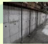
【コンクリートへの活用】
