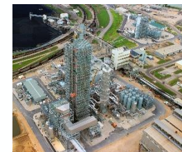
日本企業受注の世界最大級のCO2回収設備
