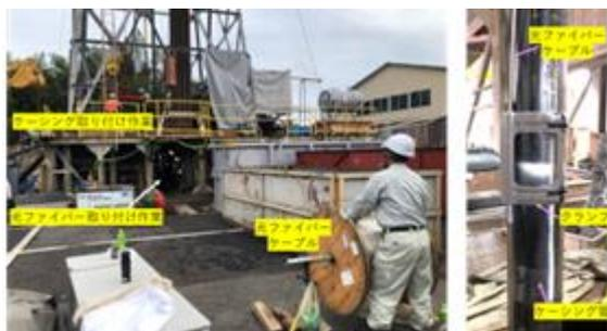
図1 国内サイトでの光ファイバー設置作業
