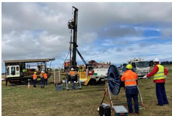
図3 Otwayサイトでの光ファイバー設置作業
