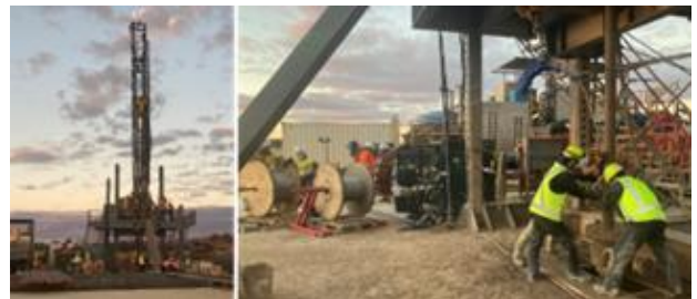
図4 豪州Perth南部サイトでの光ファイバー設置作業
