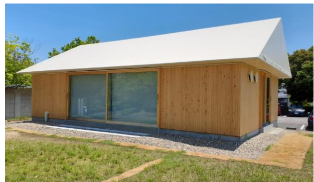
図13 DAC システム評価装置の概念図(上)と装置を設置した DAC 実験棟(下:RITE 敷地内)
